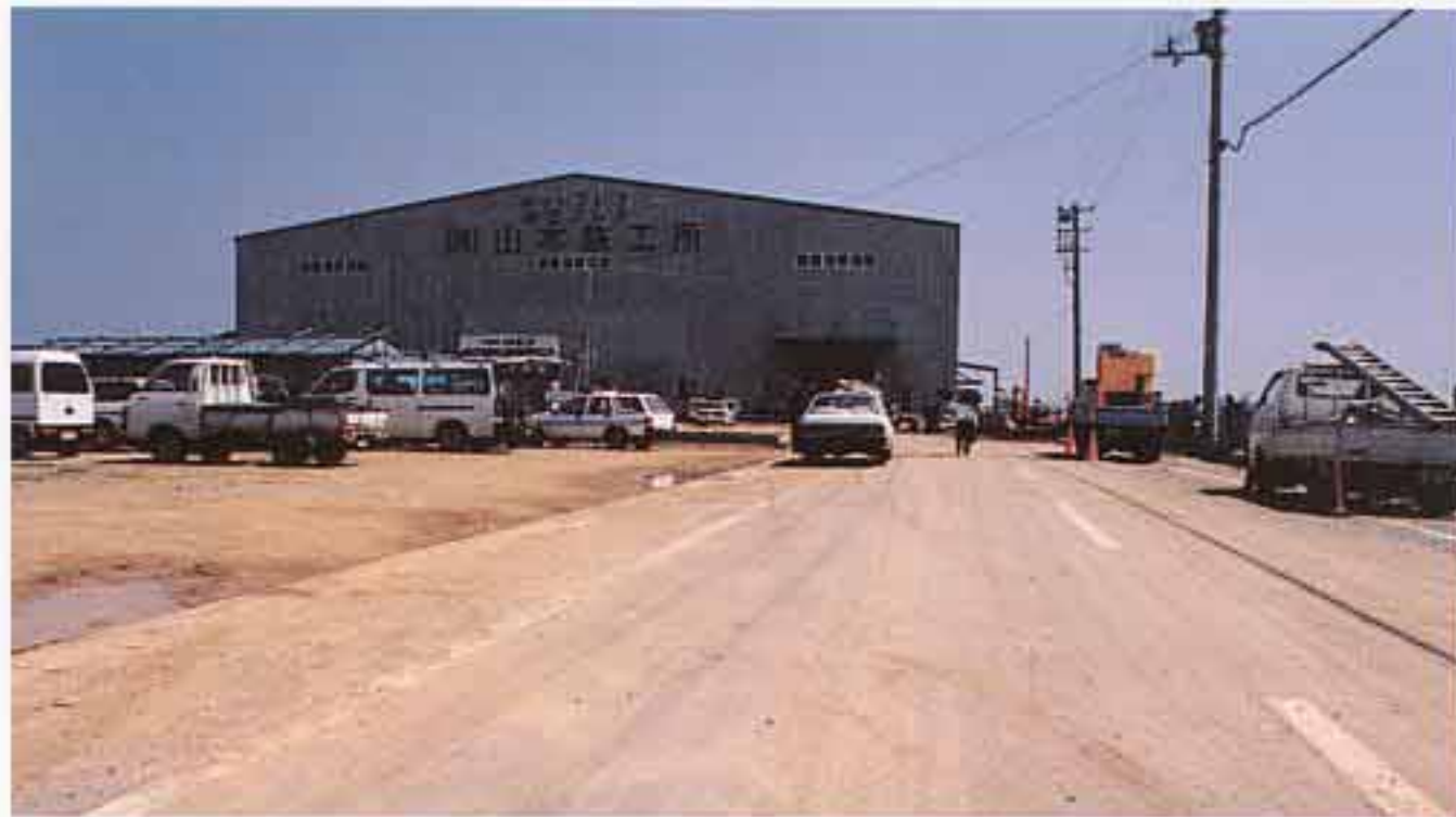
辰巳工業用地に進出した工場
