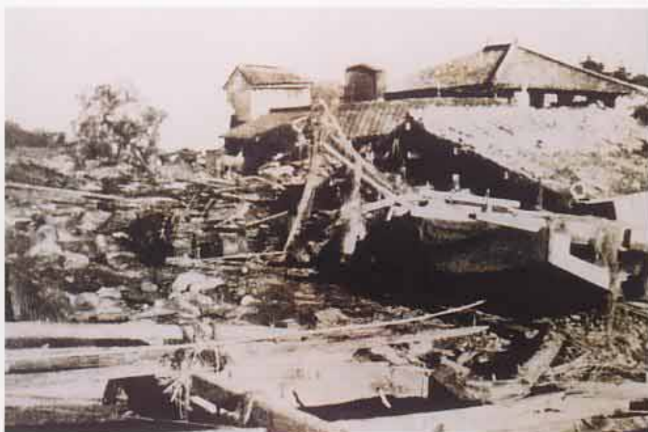
昭和21年 南海地震により倒壊した家（海南町）
