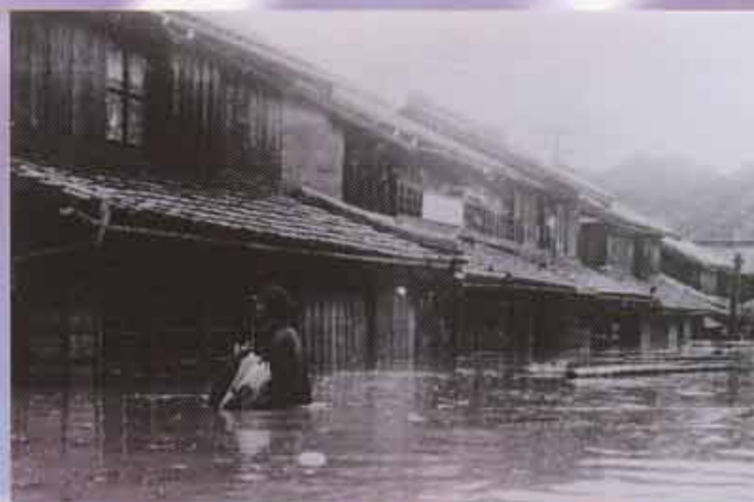
▲ジェーン台風での浸水被害（鷺敷町／昭和25年）
