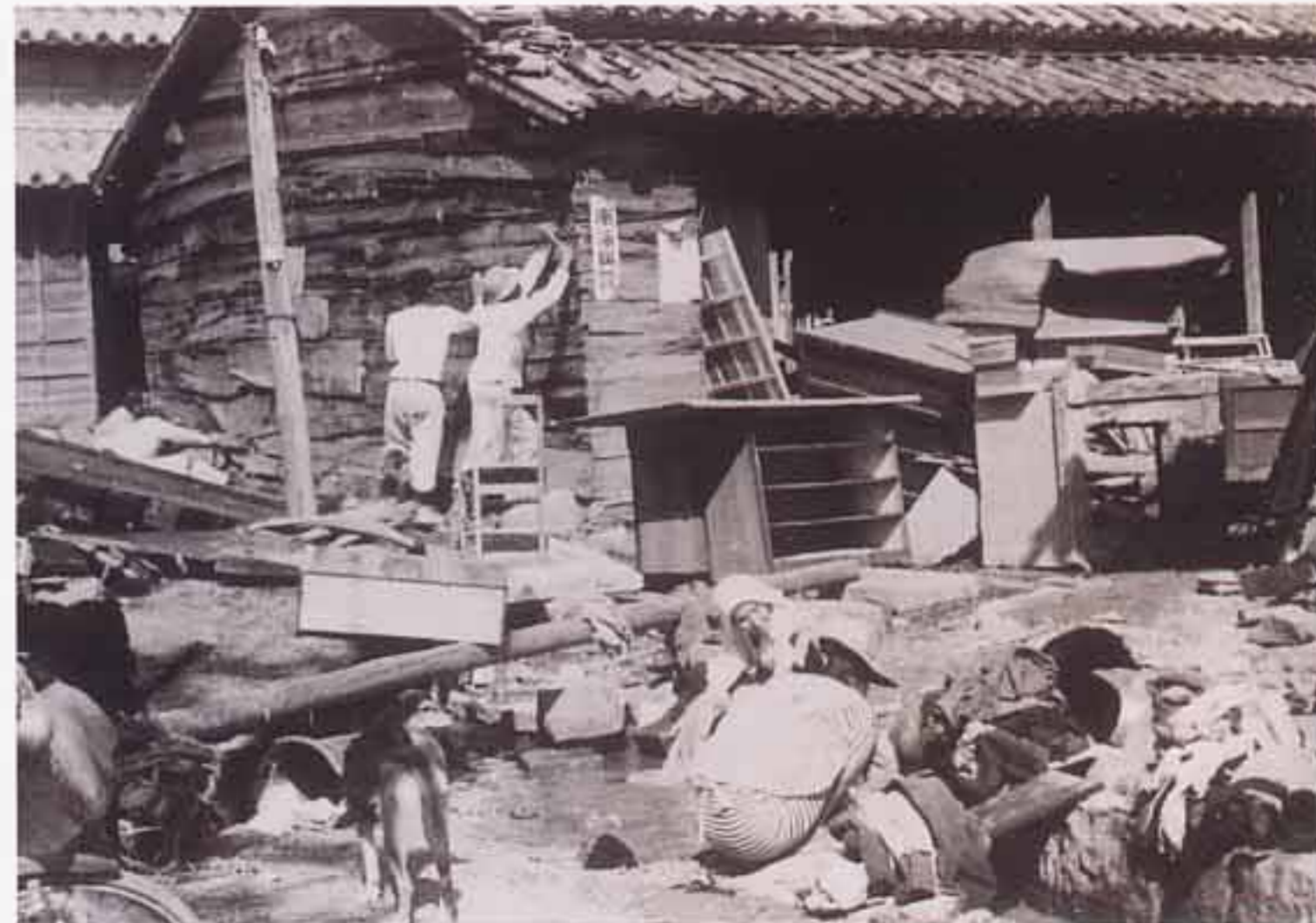
昭和36年 第2室戸台風被害 鳴門市内復旧へ向けて
