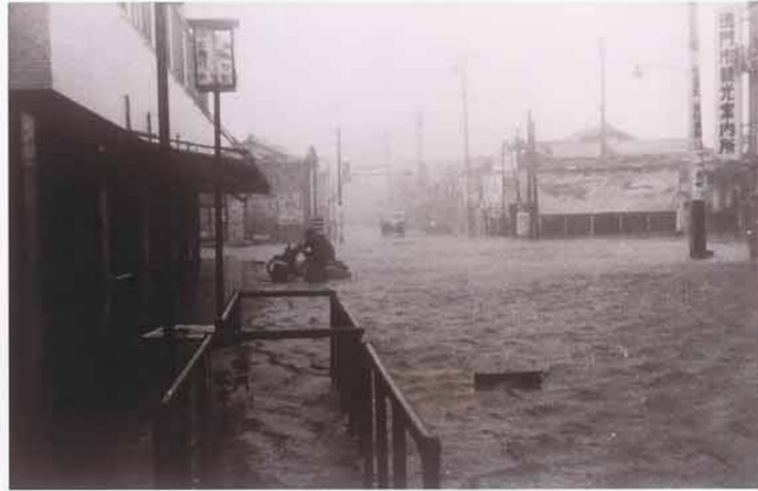
昭和25年 ジェーン台風の影響 鳴門駅前浸水
