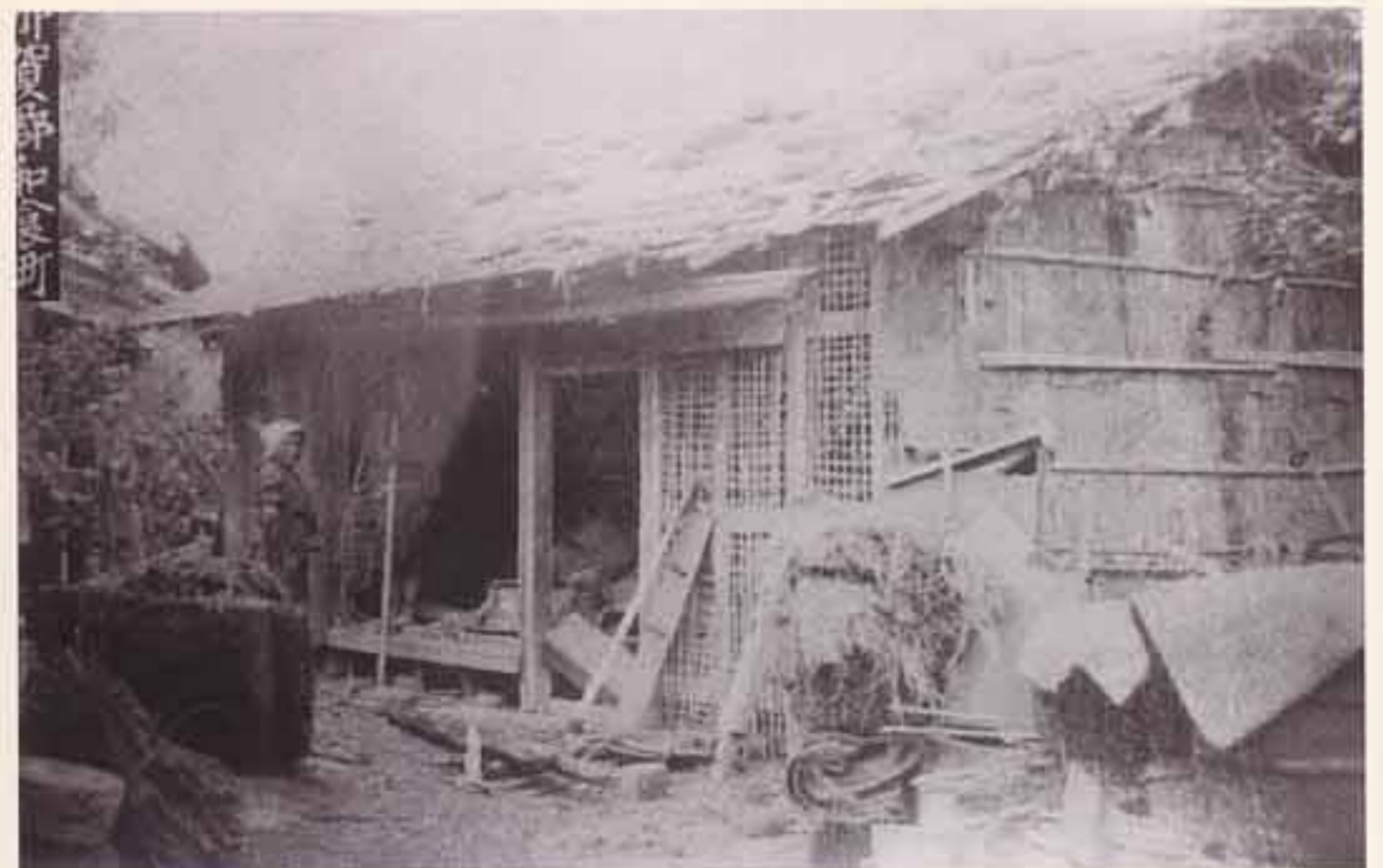
明治25年 高磯山の崩壊 「和食町（現鷺敷町）の被害」
