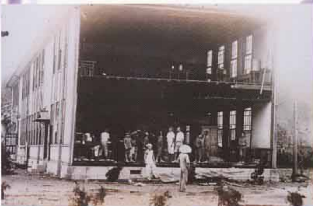
▲海部中学校標本室の被害（日和佐町／昭和9年）
