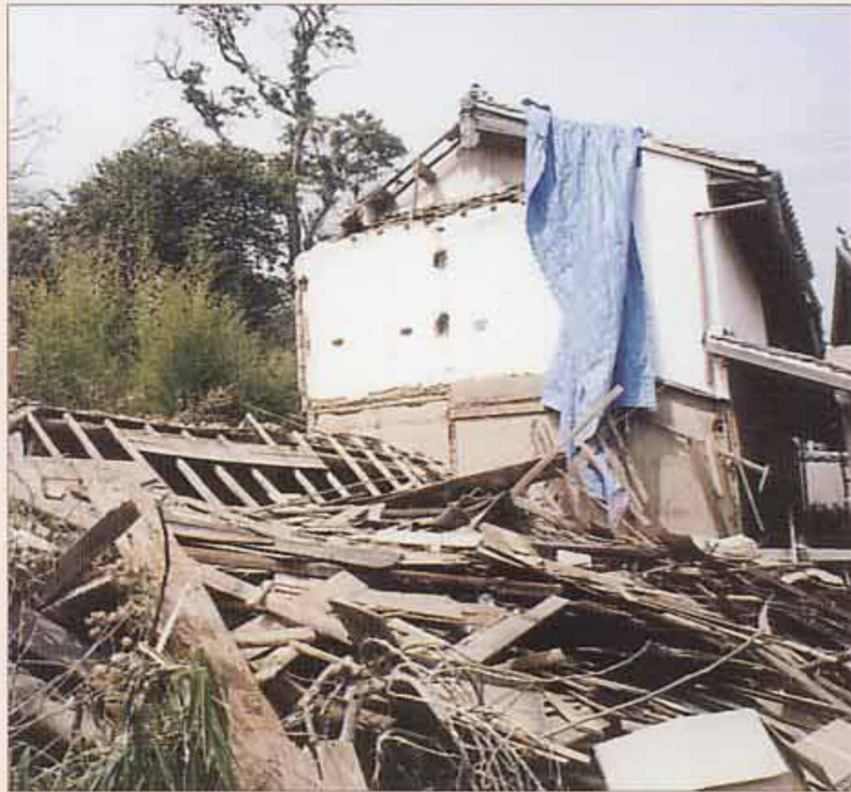
写真④ 地震で壊れた土蔵
