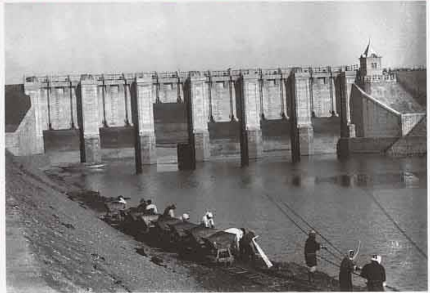
第十樋門 (現上板町)
