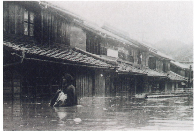
1950 (昭和25)年 ジェーン台風 床上高く浸水した街並み(驚敷町)
