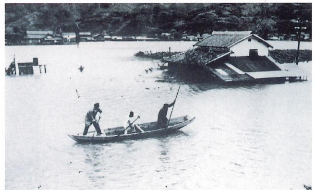
1961 (昭和36)年 第2室戸台風 河川の氾濫被害と救助船(山川町)
