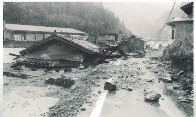
1983 (昭和58)年 台風10号 河川の氾濫で倒壊した民家(山城町)
