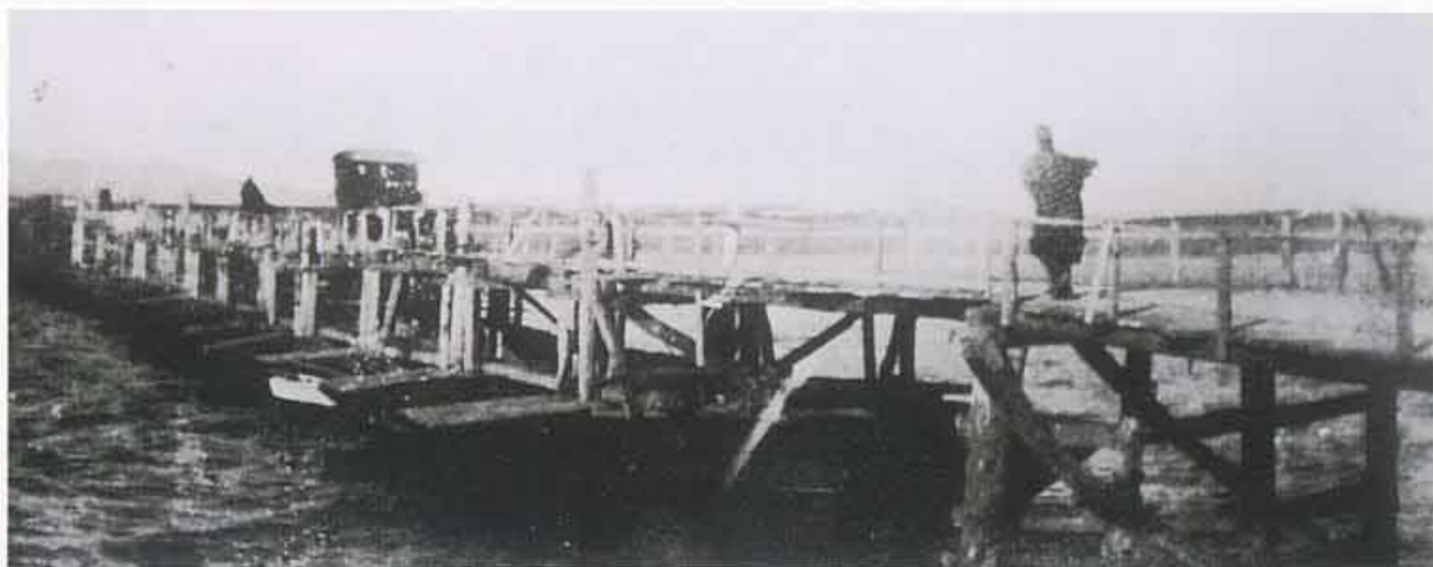
古川賃取り仮橋の船橋部を渡る撫養自動車（大正末期）
