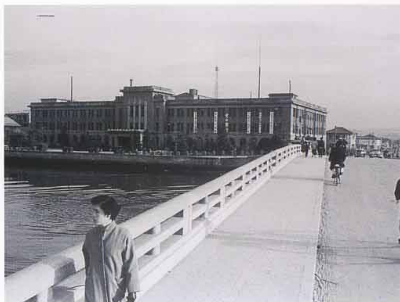
かちどき橋より徳島県庁を望む（昭和32年）
