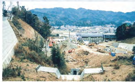
▲1987(昭和62)年12月4日 文書館南側より 文書館の建設地の造成工事中。文書館の南側には、現在と同じように山の水を流す水路が形作られている。立体駐車場にはプレハブの事務所が建ち並び、本格的な工事を進めていく準備が整えられた。
