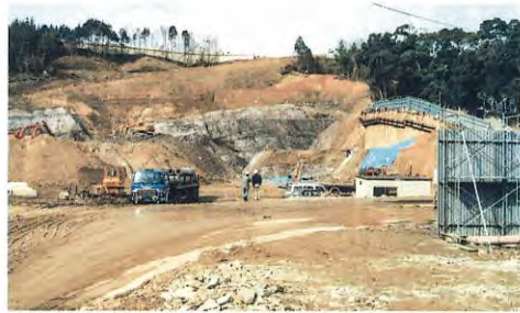
▲1988(昭和63)年3月3日 図書館東側より 図書館の土地造成工事が終了した頃。土をかなり削り取り、階段状に土地を造成している。
