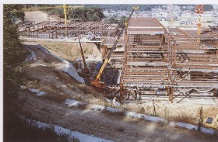
三館棟、図書館の工事
