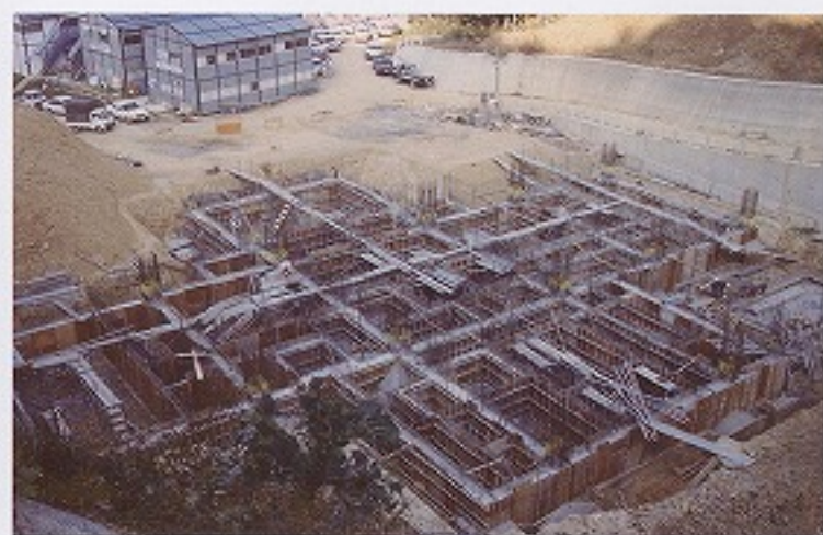
文書館基礎工事
