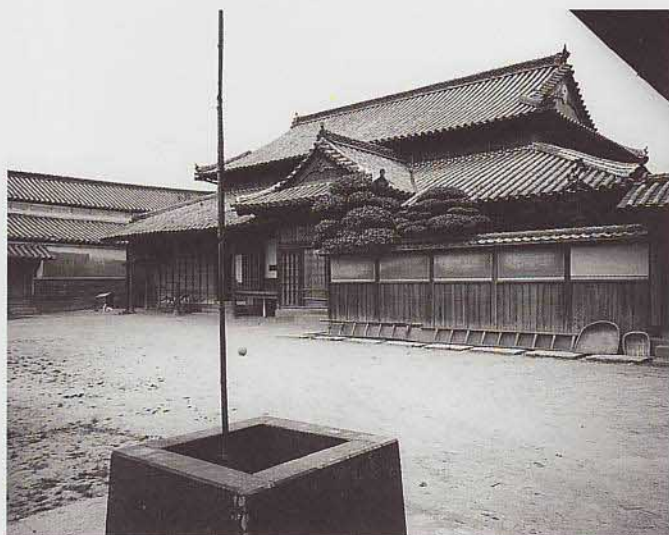
本瓦葺きの主屋と藍蔵。手前は青石の大井戸。武知邸
