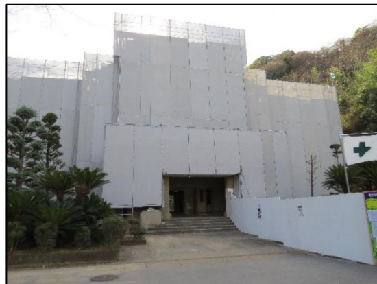
足場が組まれ囲われた文書館(正面から)
